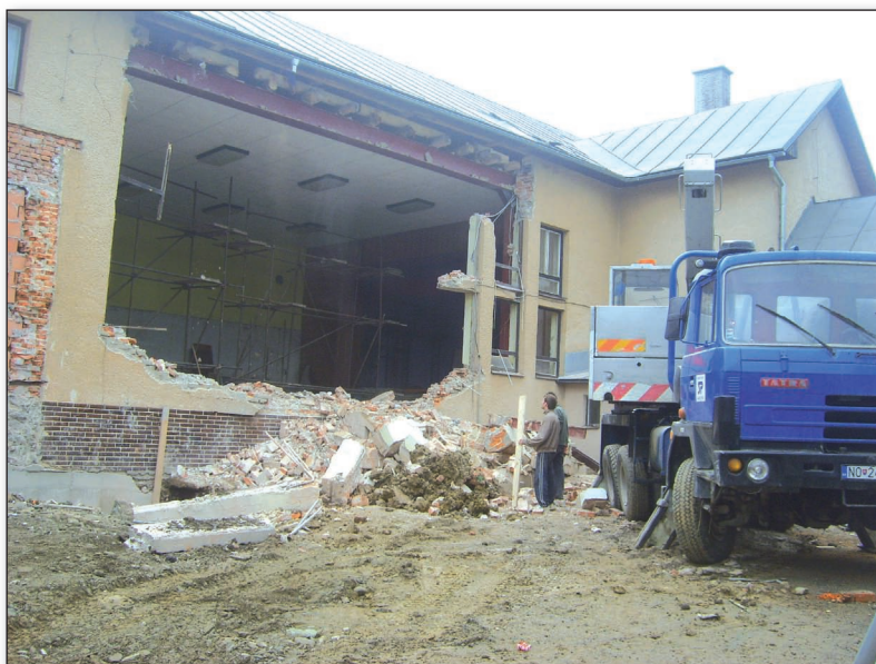
Stavebné práce bežia v plnom prúde...
