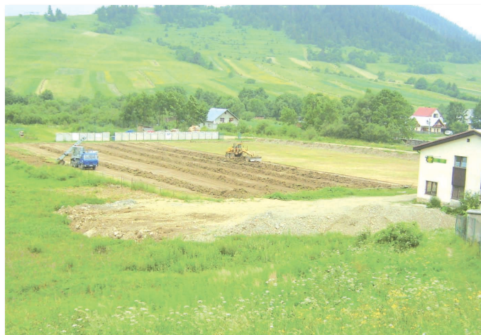
Pohľad na rekonštruovanú plochu futbalového ihriska
