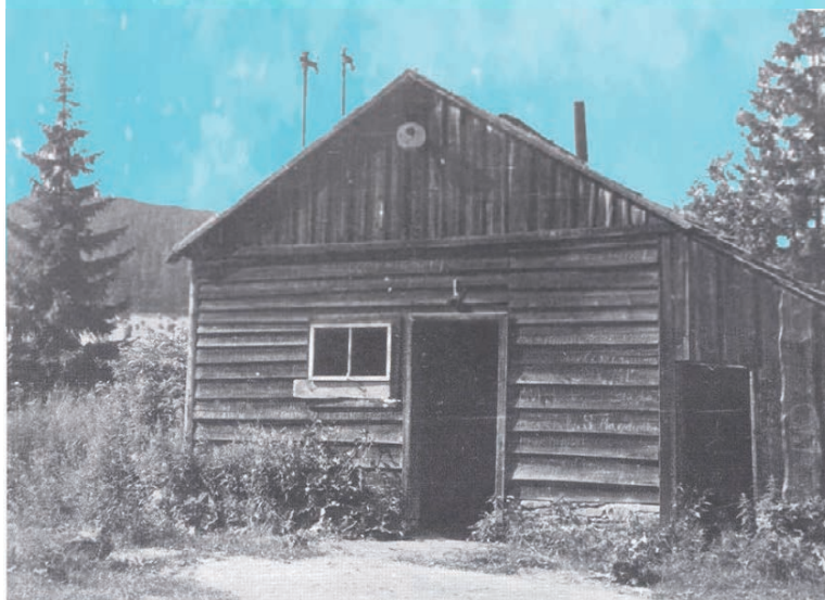
Drevená budova s odparovňou soli, 1970
